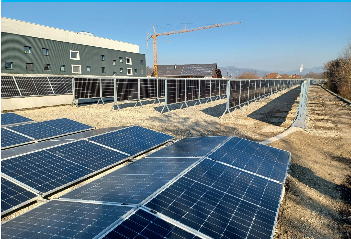
Zofingen: PV-Anlagen mit Lärmschutz und Biodiversität kombiniert.
