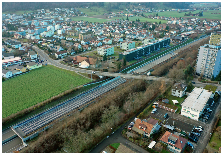
Die PV-Überdachung entlang der Autobahn in Zofingen ist einen halben Kilometer lang.
