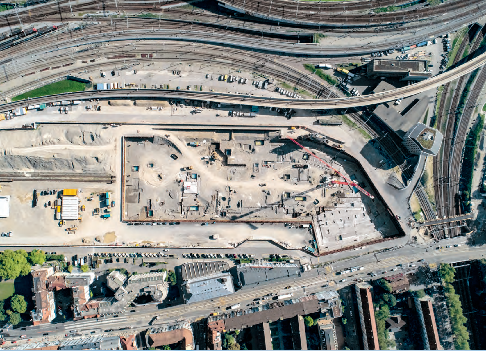
Im Sommer 2017 spielen sich die Bauarbeiten noch tief im Untergrund ab.
