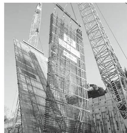
Aufrichten eines Bewehrungskorbs des Hangsicherungstragwerks.
