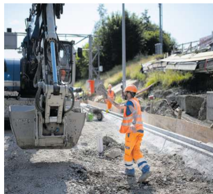
Auch neue Randsteine gehörten zur Sanierung des Trassees.
