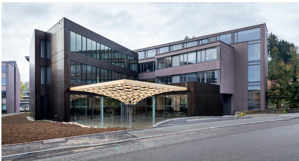
Das Holzdach des Future Tree besteht aus reziproken Knoten. Im parametrischen Modell konnten unter anderem die Maschenweite und die Wölbung angepasst werden. (Bild: Basler & Hofmann AG, Stefan Kubli)
