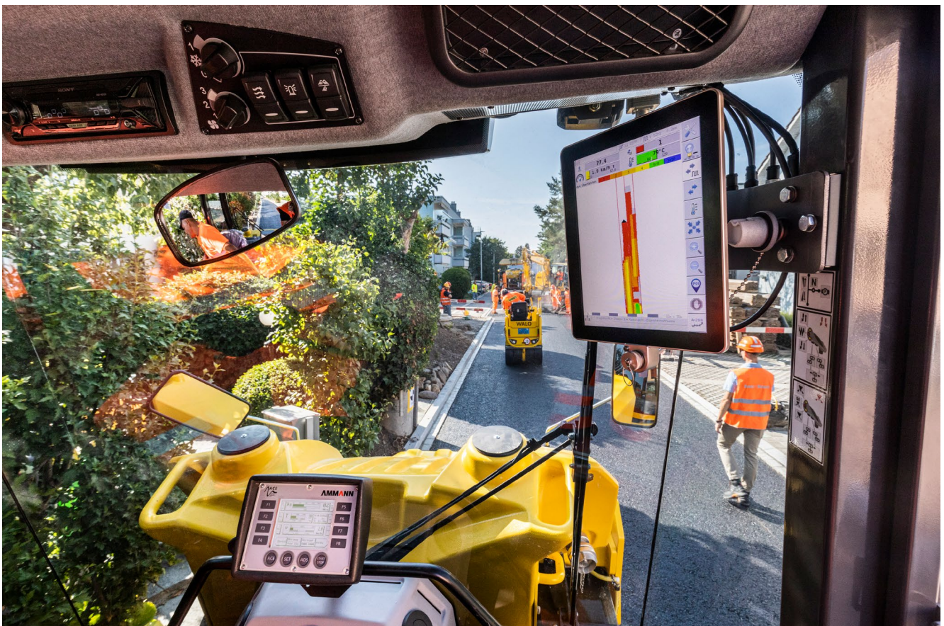
Datenerhebung während des Asphaltierens
