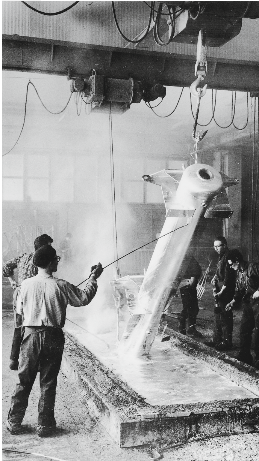
Der Prozess des Verzinkens (links). Ansicht der Verzhinkerei Zug um das Jahr 1922 (oben rechts) und des heutigen Areals von V-Zug.
