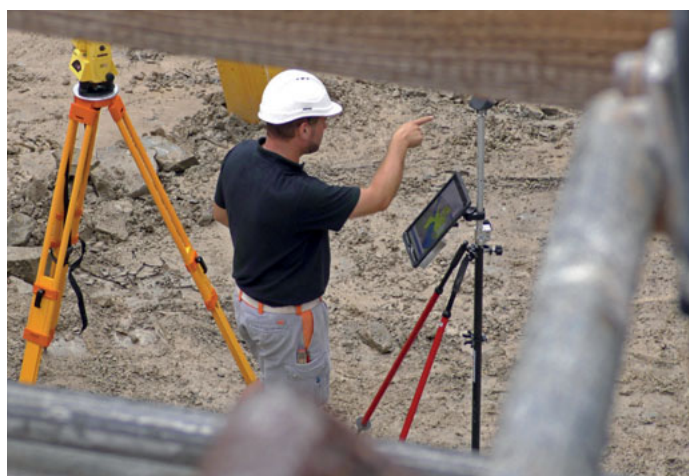
Bauen ohne Pläne: Auf der Baustelle wird auf der Basis des digitalen Zwillinges vermessen.
