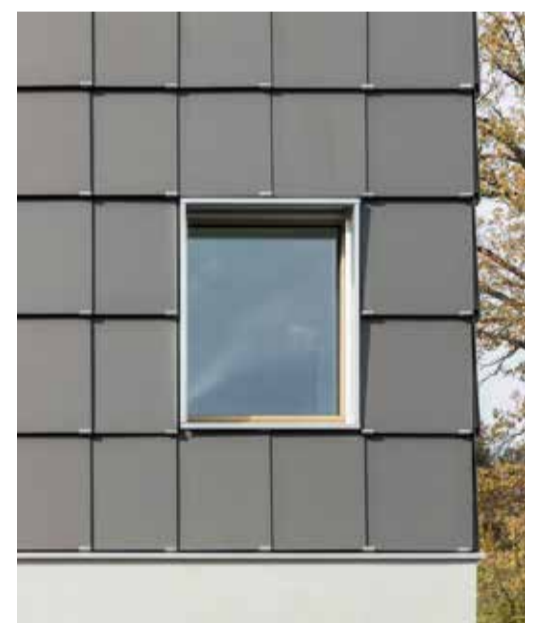
Günstige Standardisierung: Für die Fassade wurden über 1000 identische PV-Module verbaut.
