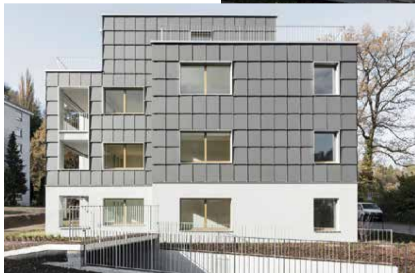
Die Schuppung der Elemente sowie ein einfaches Montagesystem halfen, die Kosten für die aktive Fassade weiter zu senken.
