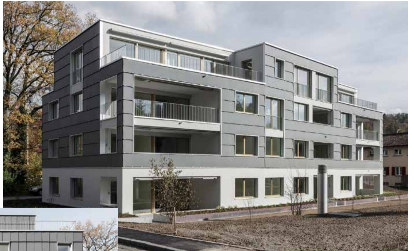
Mehr als genug Strom aus eigener Produktion: Fast die ganze Fassade des Neubaus ist mit PV-Modulen bedeckt.
