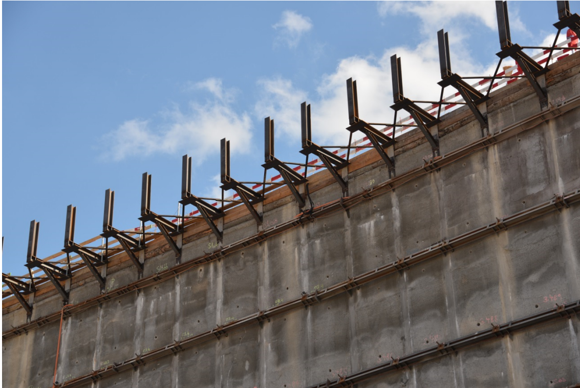
Abb. 13: Erstellung der auskragenden Logistikplattformen
