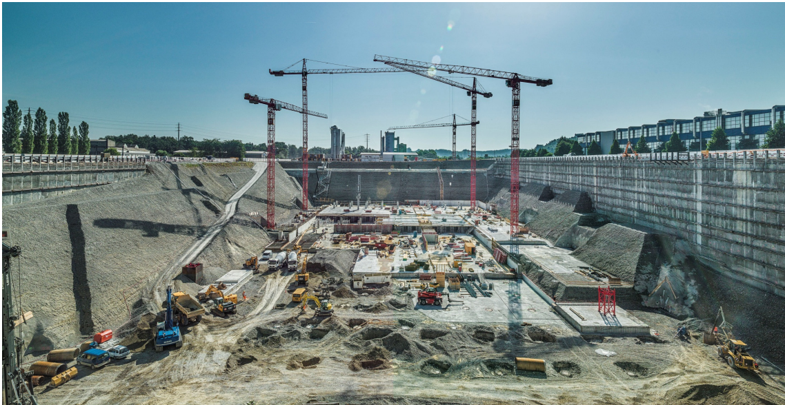
Abb. 14: Ansicht Baugrube zu Beginn des Rohbaus (Bild: Alexander Sauer)
