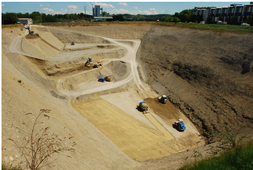
Abb. 7: Schütтарbeiten vor Baugrubenerstellung
