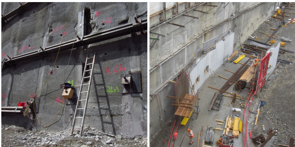
Abb. 11: Ausschnitt Rühlwand mit Ankern auf Longarinen und direkt an Trägern angeschlossene Anker im Bereich der einhäuptigen Schalung
