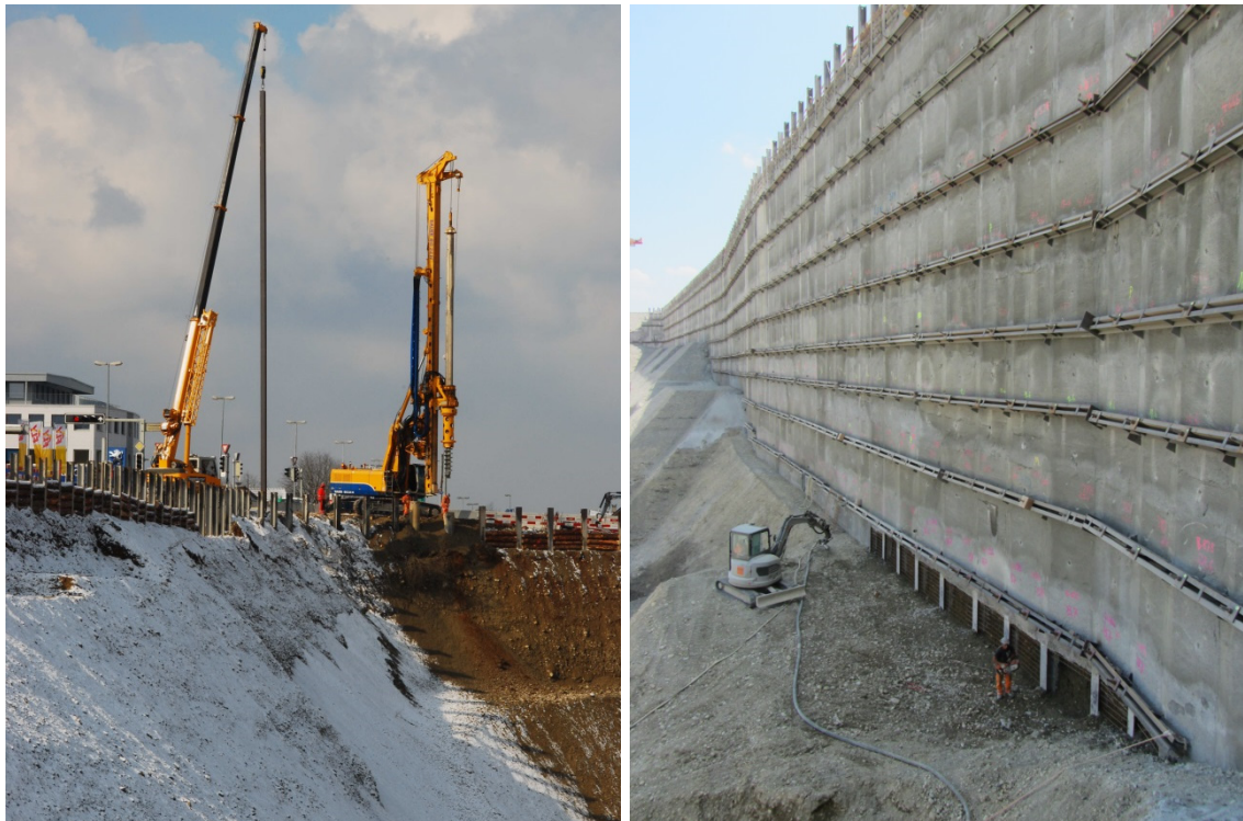
Abb. 12: Rühlwandarbeiten: Einbringen der bis zu 28 m langen Träger (links), Spritzbetonarbeiten (rechts)
