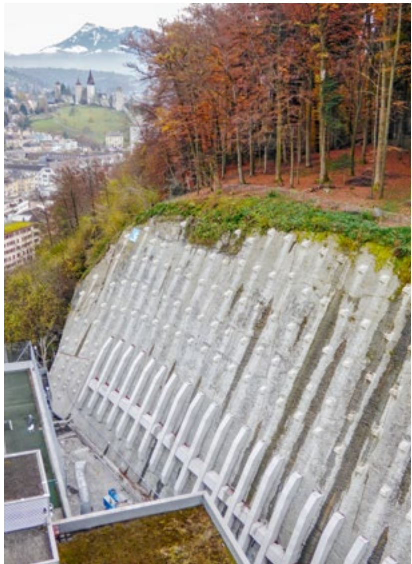
Östlicher Teil der Felssicherung im ehemaligen Steinbruch Sagenmatt, dem grössten von ehemals 20 auf Luzerner Stadtgebiet. Die Museggmauer im Hintergrund und weitere Bauten Luzerns bestehen aus derartigem Plattensandstein. Die Rigi (ganz hinten) allerdings nicht. Sie baut sich vorwiegend aus Nagelfluh auf.
