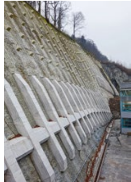
Abgeschlossene Sanierung, Blickrichtung West.
