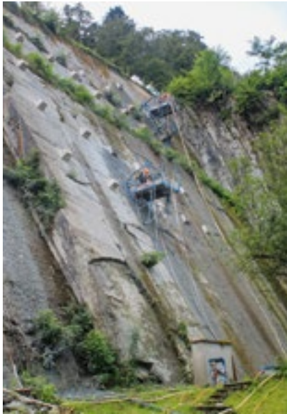
Hängende Bohrschlitten zur Erstellung der Einzelanker.
