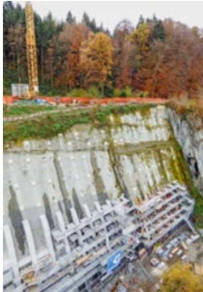
Gerüste zur Erstellung der Rippen und Longarinen.
