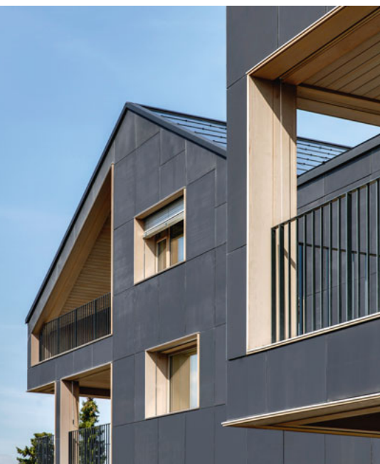
Detail Fassade mit eingeschobenen Loggien und Fensteröffnungen – die gesamte Gebäudefassade liefert Solarstrom.
