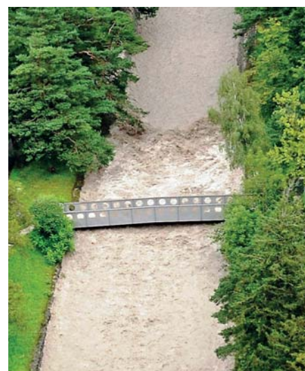
Bild 2. Der Wassersprung ober der Passelle markiert die Front der gegen die Fliessrichtung wandernden Auflandungsfront (Aufnahme am 23. August 2005, Vormittag. Copyright TBA Kanton Uri).
