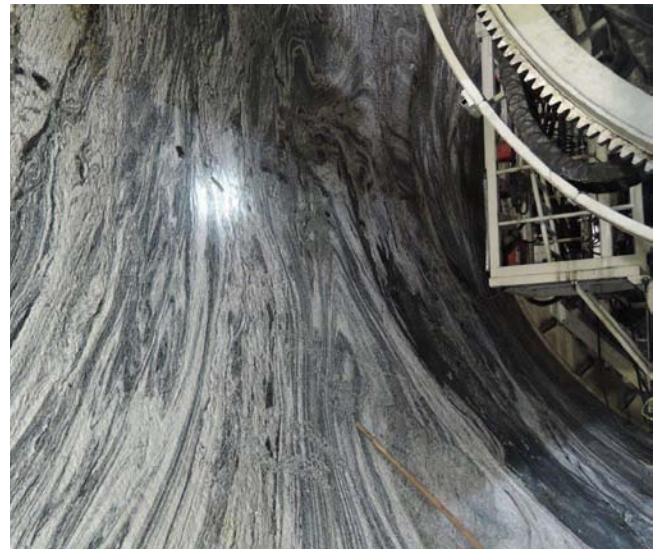
13 Der TBM-Vortrieb im Ulriken Tunnel erfolgte bislang in hartem, stabilem Fels
