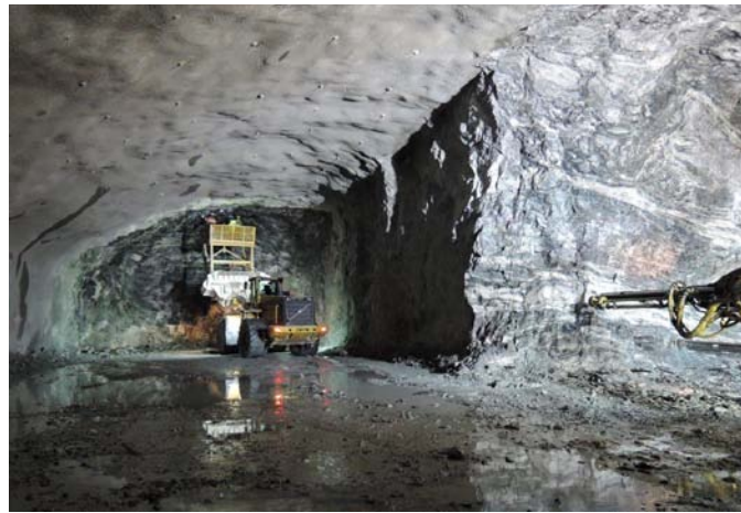
6 Sprengvortrieb Drill and blast excavation
