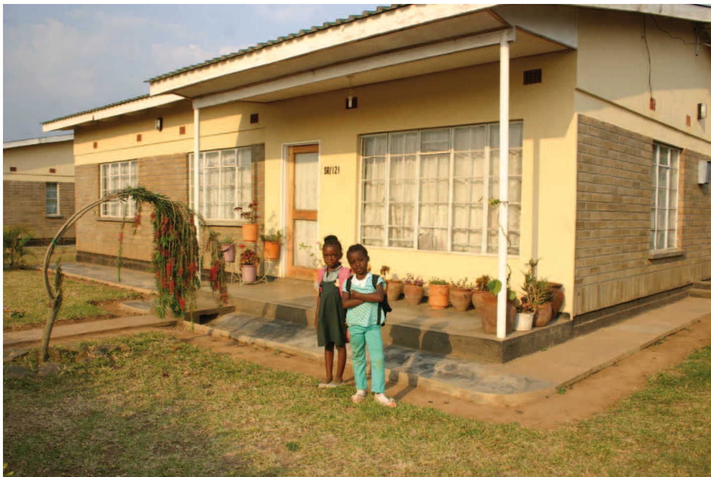
Une maison bâtie à partir de la Durabric de LafargeHolcim à Lilongwe, au Malawi
