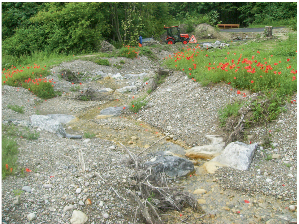
Fig. 2 Fertiger Bachlauf mit naturnaher Gestaltung (u. a. Blocksteine, Wurzelstöcke, Faschinen) Cours d'eau aménagé de façon naturelle (avec des blocs, fascines de bois morts, rhizome)
