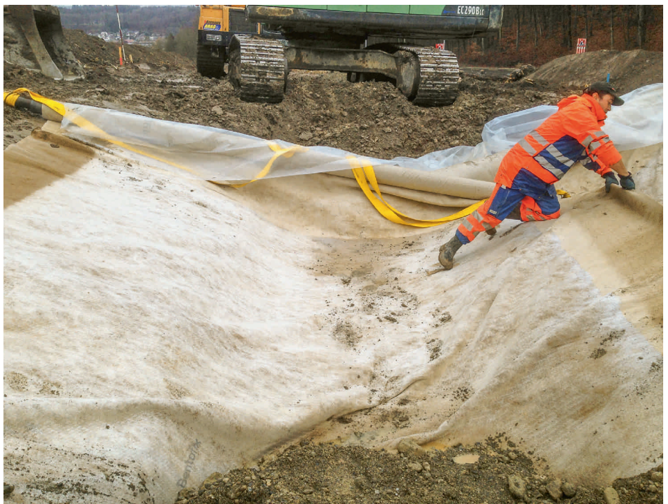
Fig. 1 Einbau Abdichtung (Bentonitmatte mit Überschüttung) Étanchéisation (natte de bentonite avec ensevelissement)
