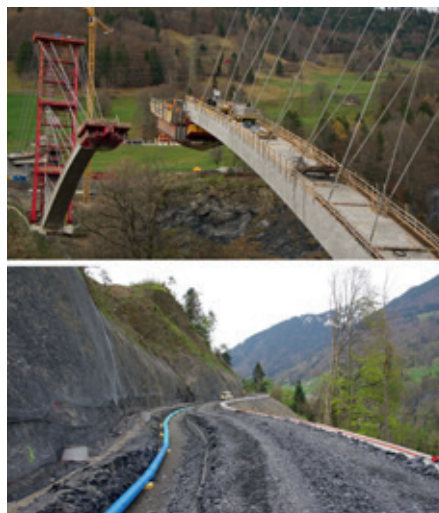
Abb. 2: Bau der Taminabrücke 2013-2017, inklusive Verbindungsstrasse.
